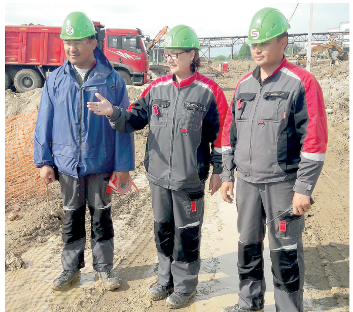
Инженер по ТБ Нурия БУРГАНОВА (в центре) и её коллеги постоянно присутствуют на стройплощадке, контролируя безопасность проведения всех видов работ
